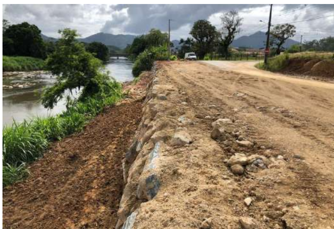
Obra de enrocamento - Rua Alwin Koch em Jaraguá do Sul
