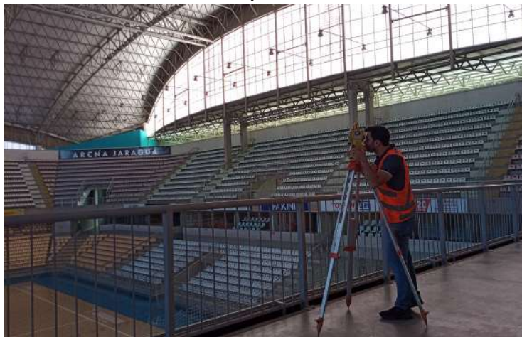
Levantamento da estrutura metálica na Arena Jaraguá
