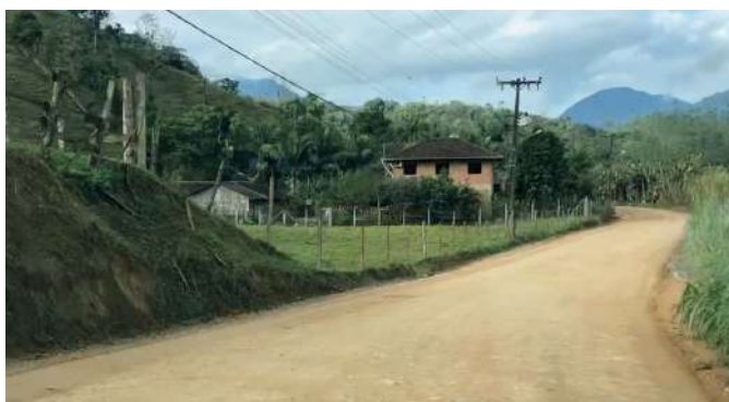
Estrada JGS 466 - Santo Estevão e JGS 481 - Gerhard Gumz Bairro Garibaldi (Antes)
