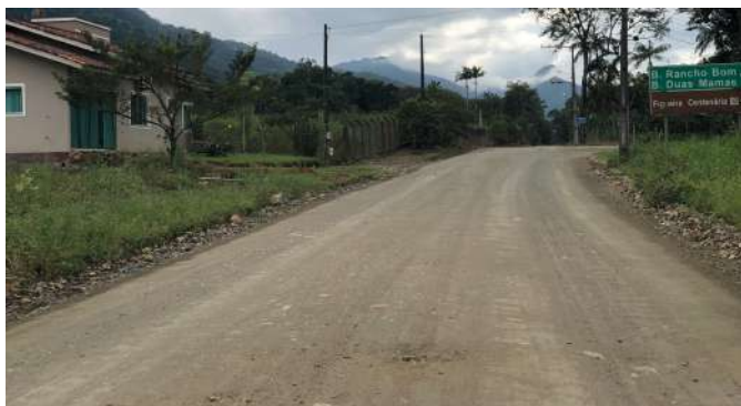
Estrada Braço do Sul - Schroeder (Antes)
