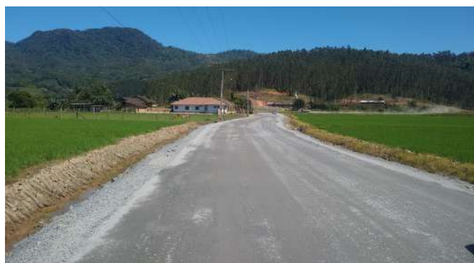
Estrada 194 - Massaranduba (Durante as obras)
