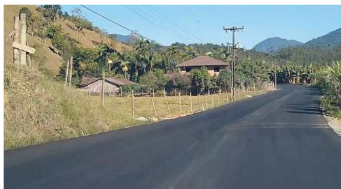
Estrada JGS 466 - Santo Estevão e JGS 481 - Gerhard Gumz Bairro Garibaldi (Durante as obras)
