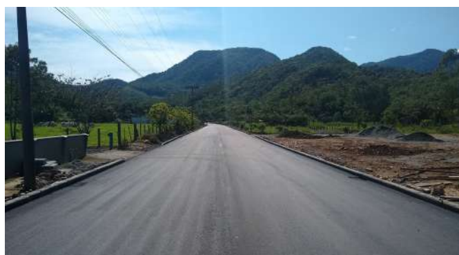
Estrada Duas Mamas - Schroeder (Durante as obras)
