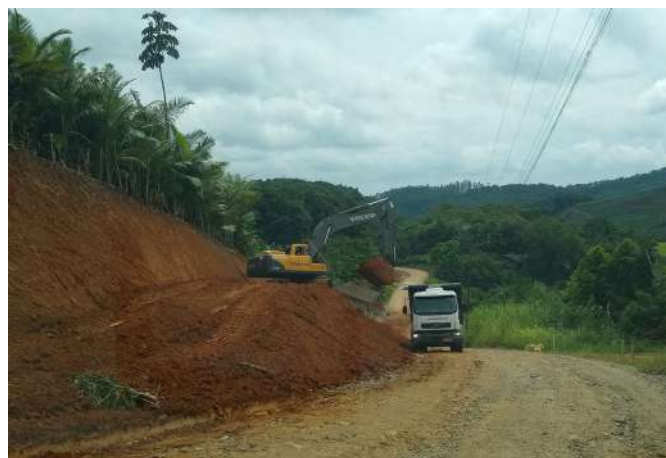
Obra de retaludamento - Estrada Guarani-Açu em Massaranduba
