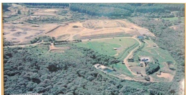
Figura 28. Aterro sanitário de tratamento e disposição final de resíduos sólidos domiciliares da empresa Serrana Engenharia Ltda., e lagoas de tratamento dos efluentes
