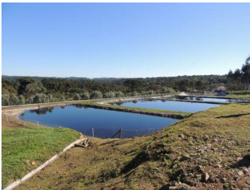
Figura 25. Sequência de lagoas de emergência para armazenamento do líquido percolado; e sistema de tratamento dos líquidos percolados composto de tratamento físico-químico
