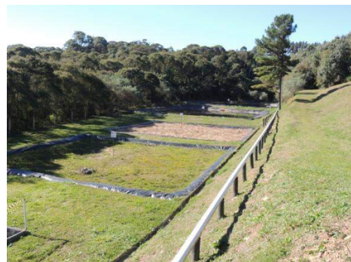
Figura 26. Reator Anaeróbio de Lodo Fluidizado; sequência de lagoas anaeróbias e facultativa, e zona de raízes
