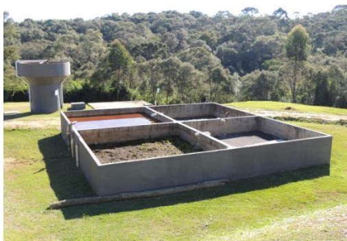
Figura 27. Leito de secagem para os resíduos sólidos gerados no tratamento; e poço de monitoramento do lençol freático
