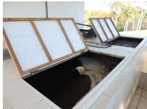
Figura 25. Sequência de lagoas de emergência para armazenamento do líquido percolado; e sistema de tratamento dos líquidos percolados composto de tratamento físico-químico
