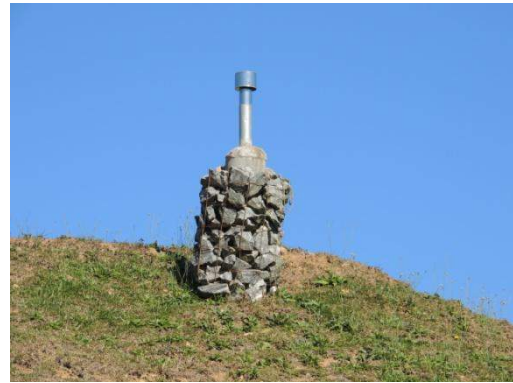
Figura 24. Sistema de drenagem e queima dos gases gerados
