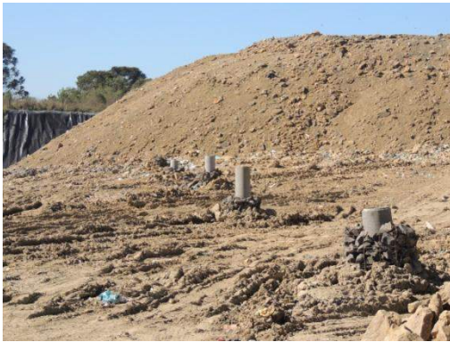
Figura 24. Sistema de drenagem e queima dos gases gerados
