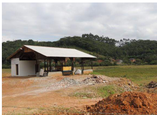
Figura 42. Aterro de inertes no município de Guaramirim, para onde são levados os RCC coletados Fonte: Acervo próprio
