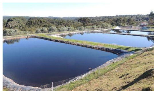
Figura 28. Aterro sanitário de tratamento e disposição final de resíduos sólidos domiciliares da empresa Serrana Engenharia Ltda., e lagoas de tratamento dos efluentes
