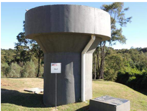
Figura 26. Reator Anaeróbio de Lodo Fluidizado; sequência de lagoas anaeróbias e facultativa, e zona de raízes
