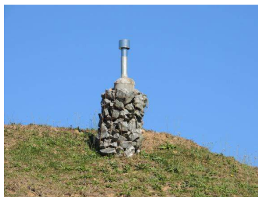
Figura 23. Sistema de drenagem e queima dos gases gerados
