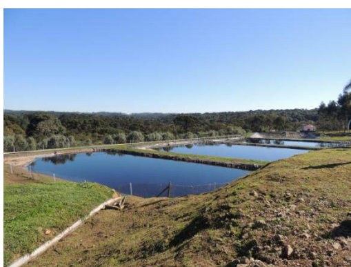
Figura 24. Sequência de lagoas de emergência para armazenamento do líquido percolado; e sistema de tratamento dos líquidos percolados composto de tratamento físico-químico
