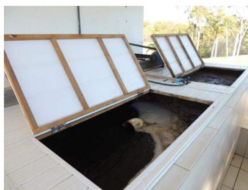
Figura 24. Sequência de lagoas de emergência para armazenamento do líquido percolado; e sistema de tratamento dos líquidos percolados composto de tratamento físico-químico
