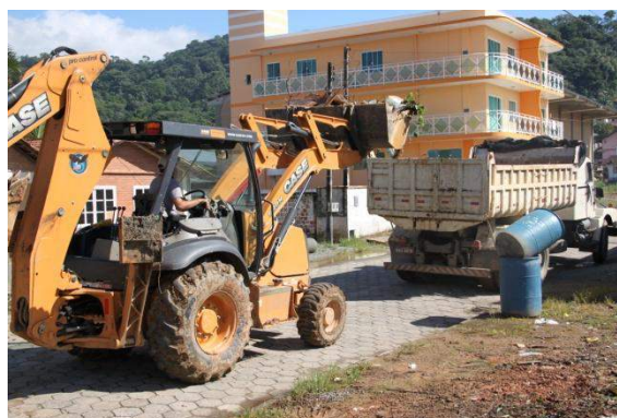
Figura 39. Operação de recolhimento de entulhos do município
