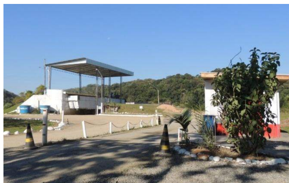
Figura 21. Estação de transbordo de resíduos sólidos domiciliares da empresa Serrana Engenharia Ltda., em Jaraguá do Sul
