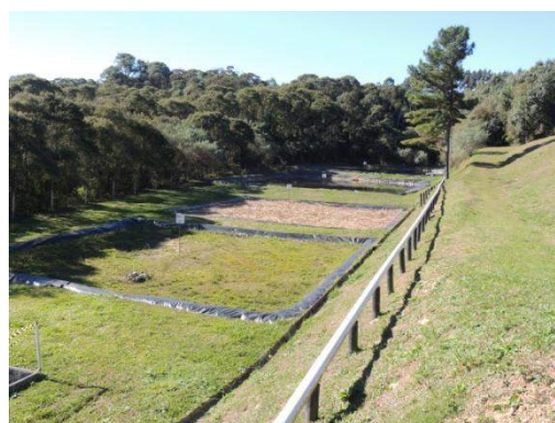
Figura 25. Reator Anaeróbio de Lodo Fluidizado; sequência de lagoas anaeróbias e facultativa, e zona de raízes
