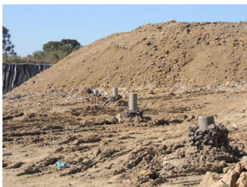
Figura 23. Sistema de drenagem e queima dos gases gerados
