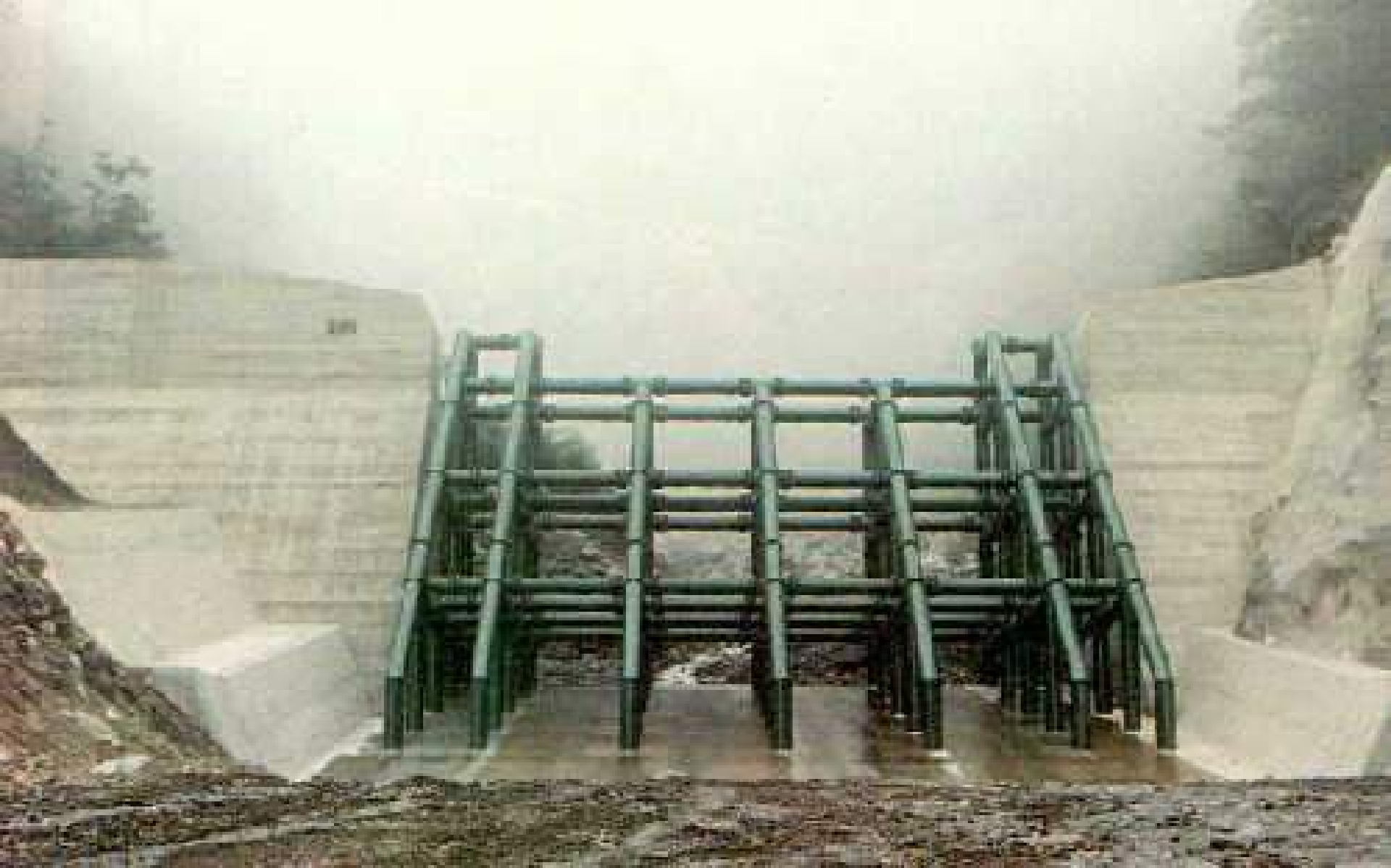
Barragem de grade contra fluxo de escombros
