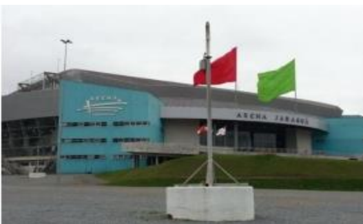
Figura 86 – Parte da área do antigo lixão de Jaraguá do Sul contempla atualmente o estacionamento da Arena Jaraguá e contém dispositivos queimadores de gás.
