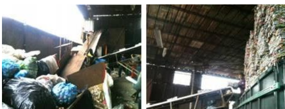
Figura 59 – Estrutura da Mader Sucatas em Jaraguá do Sul
