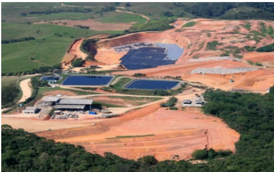
Figura 26 – Aterro sanitário de tratamento e disposição final de resíduos sólidos domiciliares da empresa Recycle Catarinense de Resíduos Ltda.
