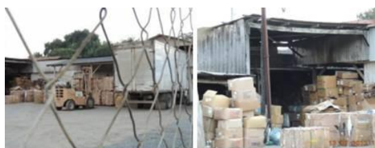
Figura 57 – Estrutura da Brascones em Guaramirim
