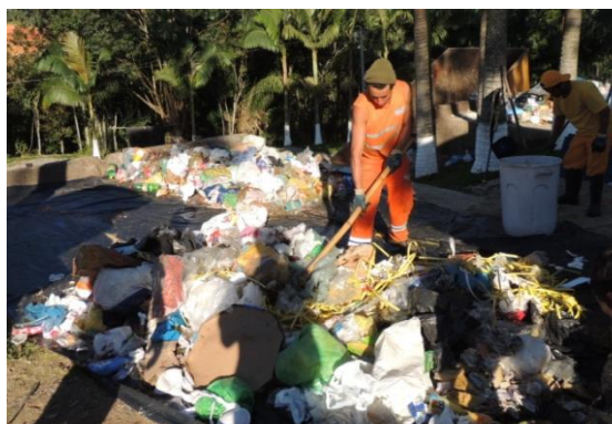
Figura 78 – Homogeneização dos resíduos resultantes do primeiro processo de quarteamento
