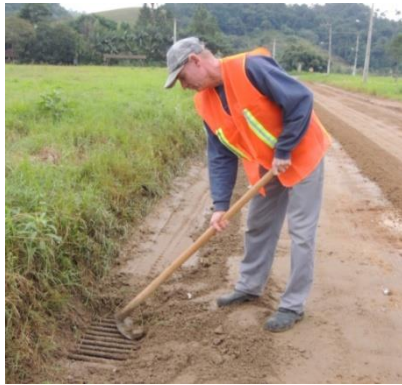
Figura 31 – Limpeza pública (limpeza de dispositivo de drenagem) em Jaraguá do Sul
