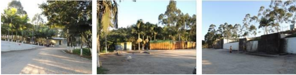
Figura 23 – Estação de transbordo de resíduos sólidos domiciliares da empresa Recycle Catarinense de Resíduos Ltda., em Piçarras.
